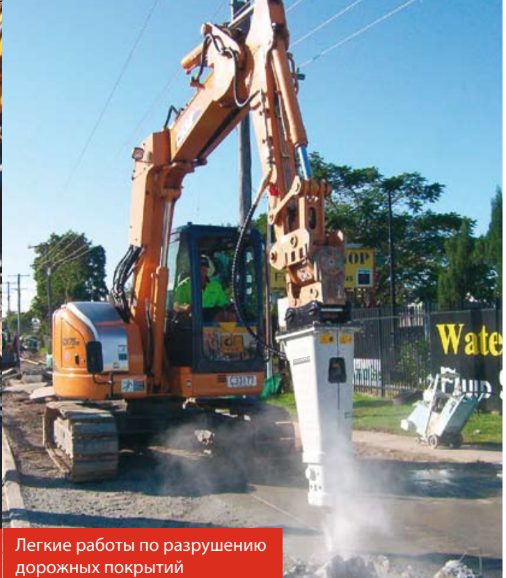
Легкие работы по разрушению дорожных покрытий
