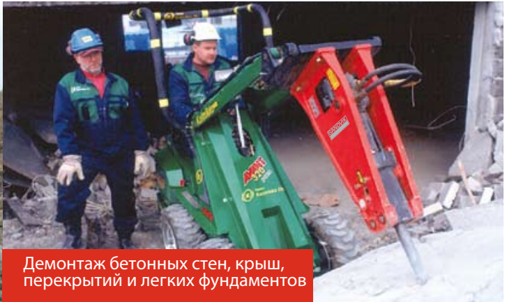
Демонтаж бетонных стен, крыш, перекрытий и легких фундаментов
