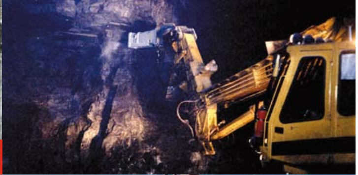
Оборка стенок и кровли тоннелей и горных выработок
